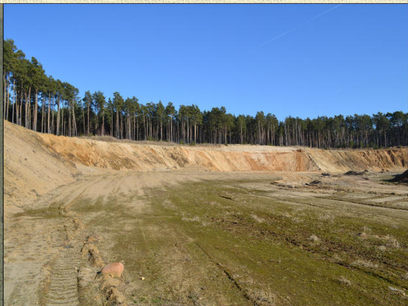
Bodenansicht aus westlicher Richtung auf den möglichen ersten Bauabschnitt der DK1 in der Fresdorfer Heide
